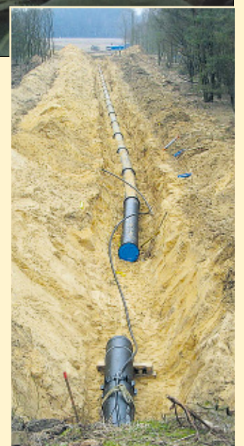
Die Trinkwasserfernleitung in ihrem neuen Bett.
