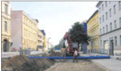
Auswechslung der Trinkwasserleitung in der Leipziger Straße.
