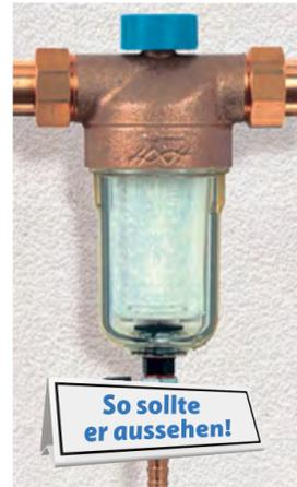
Beide Fotos zeigen rückspülbare Filter. Der linke befindet sich in gutem Zustand, der rechte wurde zu lange nicht gereinigt.
