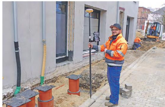
Rocco Haberland, FWA-Vorarbeiter der Gruppe Bau, bedient die neue GeoAce-App. Sie leistet wichtige Dienste bei der Vermessung von Trinkwasser-Hausanschlüssen. Kleines Foto: Der Empfänger der Navigationsdaten misst punktgenau.
