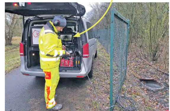
Von oben steuert der Fachmann die Kameradrohne. Auf dem Kontrollmonitor prüft er, ob alle notwendigen Abschnitte gefilmt werden.
